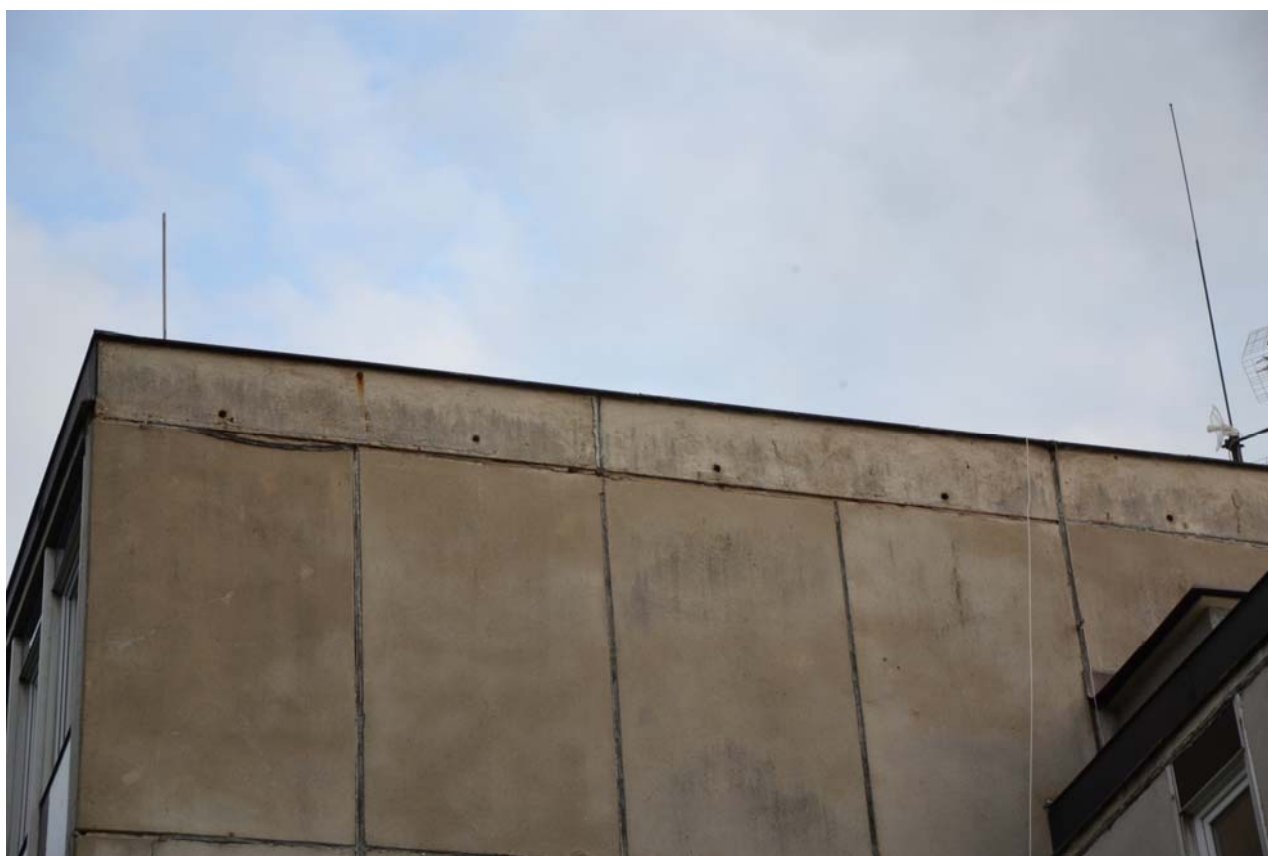
Obr 3 a 4: Větrací otvory zejména na čtyřpodlažní části objektu jsou prostupné.
